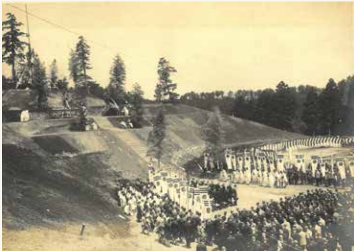
八紘之基柱起工式(昭和14年5月20日宮崎神宮奉仕) / 翌年11月15日に竣工。
